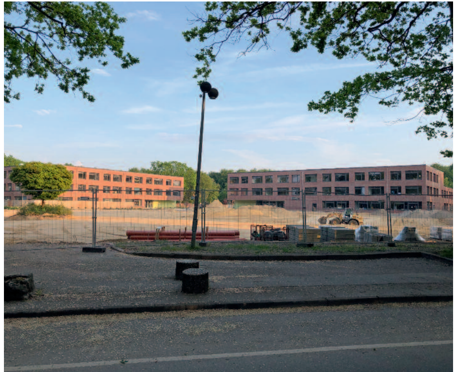
Zahlreiche Neubauten von Schulen (hier Irena-Sendler-Schule), nur nicht in Berne!
